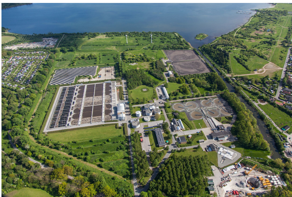
Renseanlæg Damshusåen. Foto: Hviid Photography
